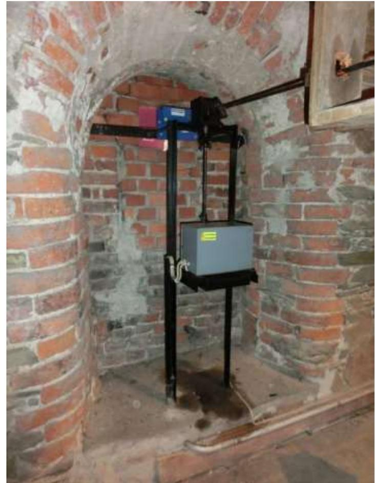
Über die sog. Zeigerleitung wird die Drehbewegung zum Kegelradverteiler übertragen. Dieser überträgt die Drehbewegung dann zu den restlichen 3 Zeigerwerken.
