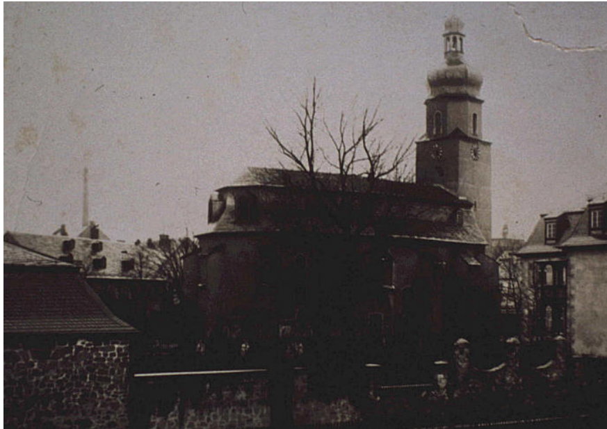
St. Jakobus vor dem Umbau
